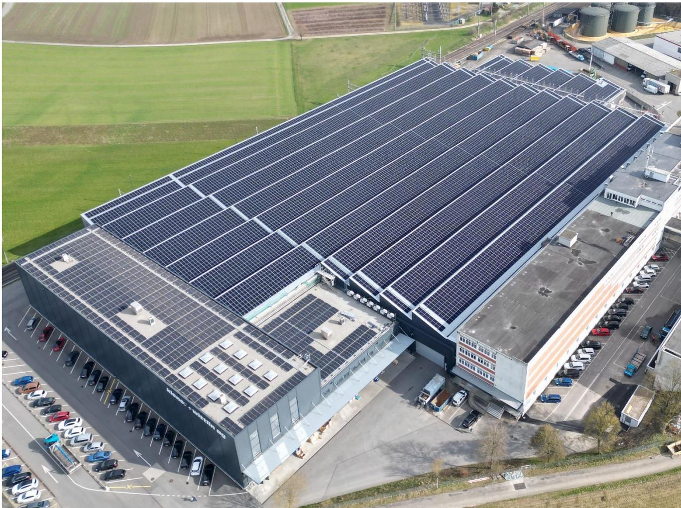
Mit der dritten und grössten Etappe wurde im März 2024 die PV-Anlage mit einer Gesamtleistung von jährlich 3.4 Gigawattstunden in Betrieb genommen. Damit ist die Anlage aktuell die zehntgrösste in der Schweiz und eine Erweiterung ist bereits in Umsetzung.
